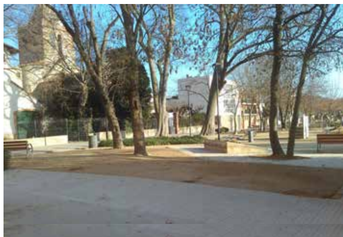
La plaça de l'Església sense els contenidors soterrats.
